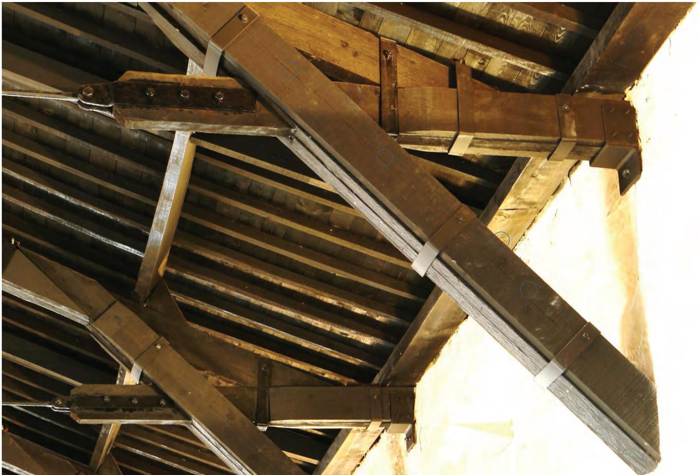
**Pormenor de ligação entre pernas de madeira das asnas e as paredes de alvenaria de pedra - solução de reforço (Trabalho T9)**
