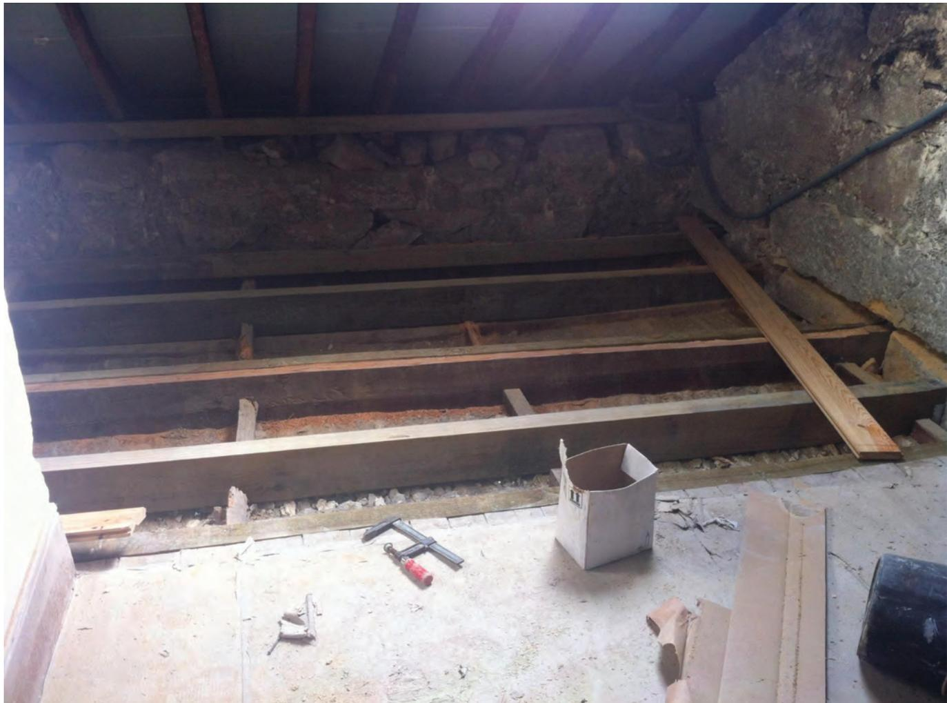
**PORMENOR - Apoio das novas vigas de madeira nas paredes de alvenaria de pedra**
